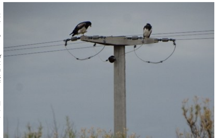
Figura. Ejemplares adultos de Águila mora ( Geranoaetus melanoleucus ) sobre poste con puentes por debajo de cruceta implementados como medida de mitigación de la electrocución en el oeste de La Pampa, Argentina.
